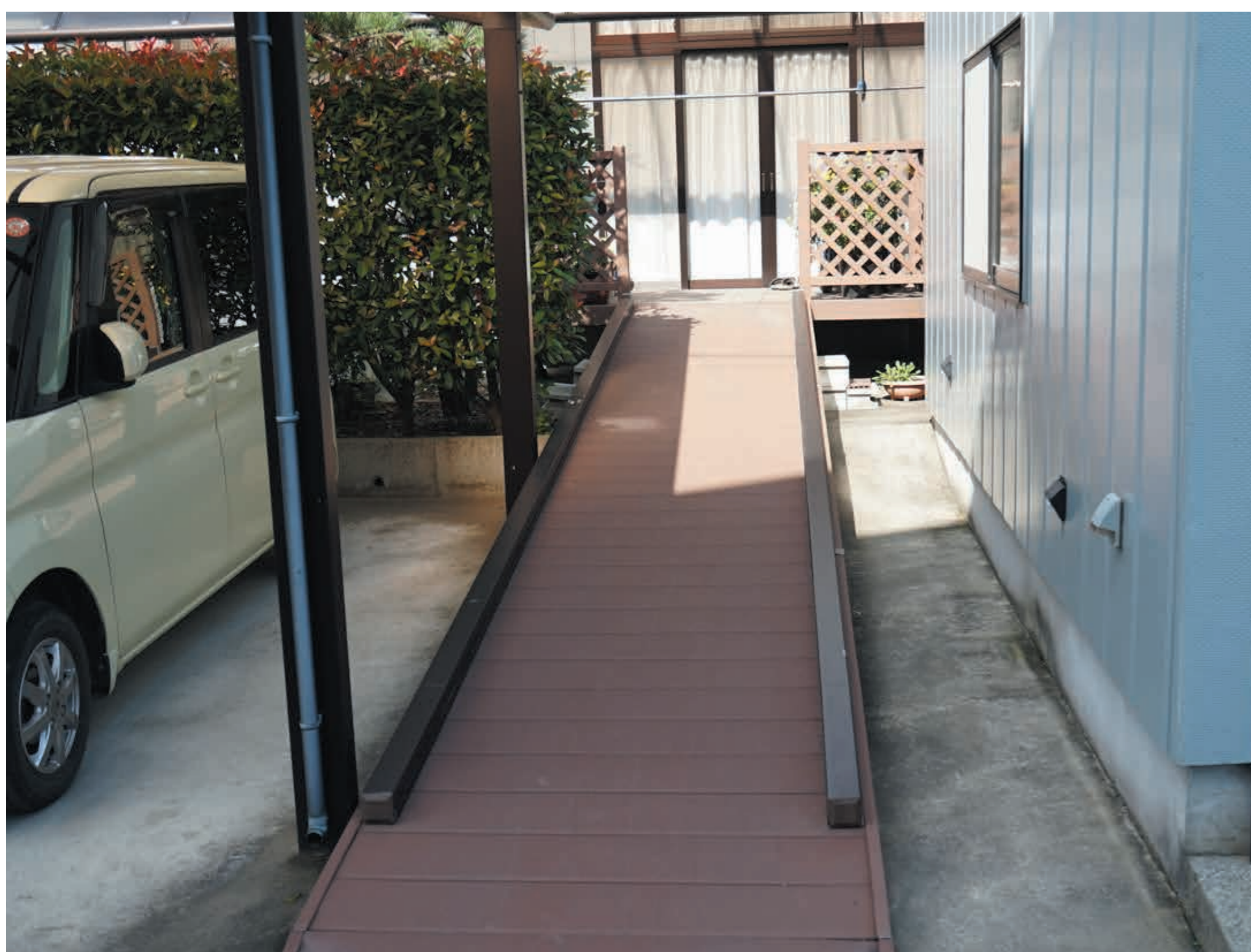
— 自宅の正面にはスロープが設置されている —
