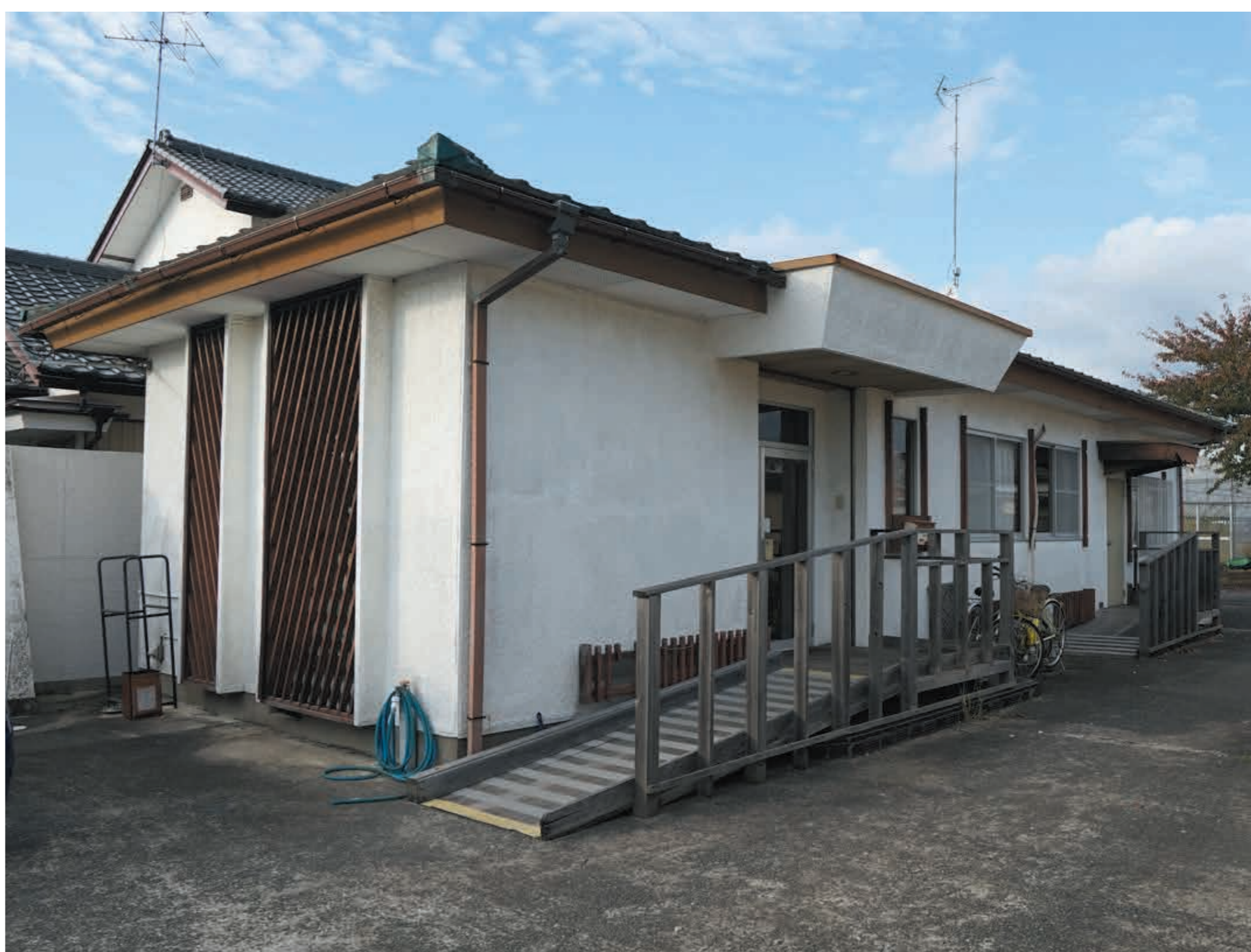
— 「障害がい者ベース石巻によっきり団」の事務所 —
